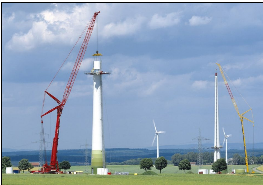
Afbeelding 1 Twee Liebherr's LTM1500-8.1 uitgerust met verstelbare hulpgiek (foto: Liebherr)
