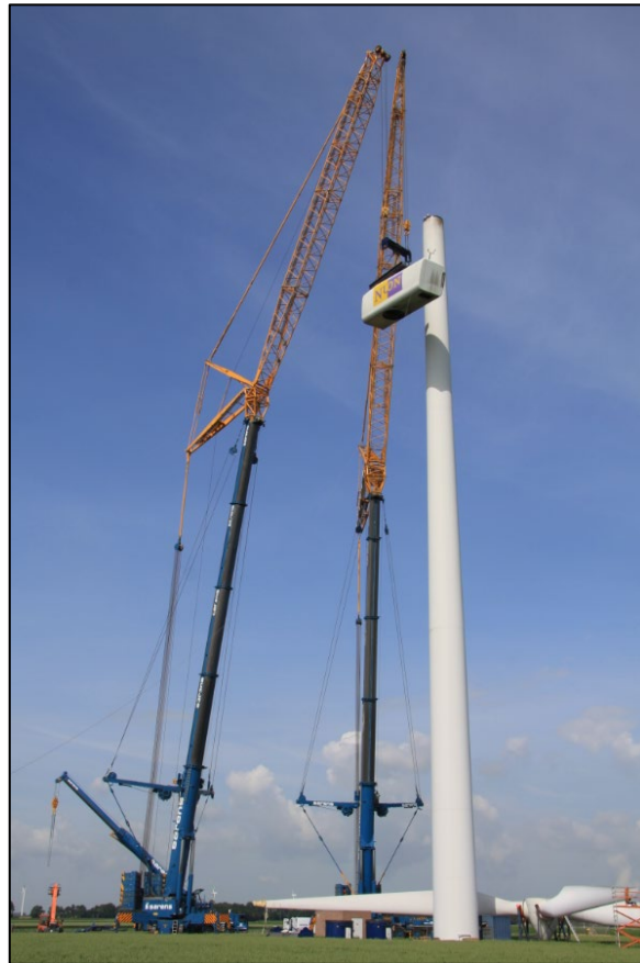
Afbeelding 4 Twee keer een Demag AC500-2 met verstelbare hulpgiek en afspanning in V-stand (foto: E. Konijn)
