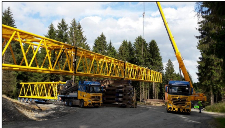
Afbeelding 14 Een verhoogde giekondersteuning bij een sterk aflopend terrein (foto: BKV)
